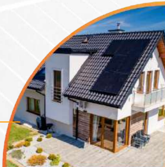
Instalacje fotowoltaiczne dla domów jednorodzinnych
